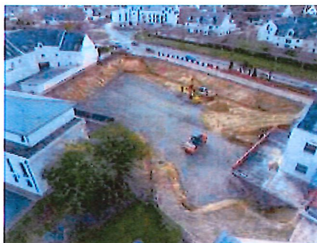
Les travaux d'extension de l'Hôtel communautaire ont débuté en novembre 2022.
