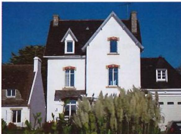
*L'enduit couvre la maçonnerie tout en maintenant apparent les linteaux décoratifs*
