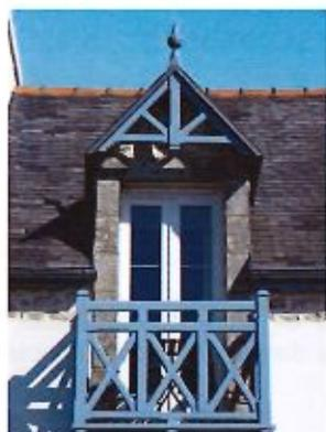
En lucarnes passantes : la position de la chute d'eau pluviale doit être examinée par rapport à l'architecture ; elle ne doit pas « couper » la lucarne en deux
